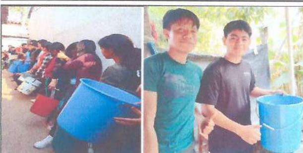
Foto 5 y 6: REPARACIÓN DE RED DE AGUA POTABLE: La comunidad educativa requiere mejora de la red de agua ya que es esencial para los que integramos la comunidad educativa.
