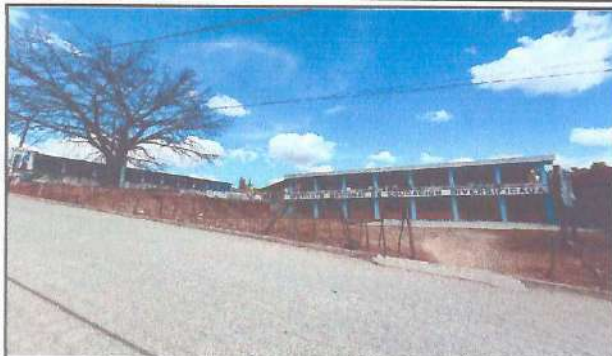
Foto 1: MURO PERIMETRAL: La comunidad educativa demanda la necesidad de circulación del centro educativo para la seguridad de los muebles he inmuebles así como a los que lo integran.
